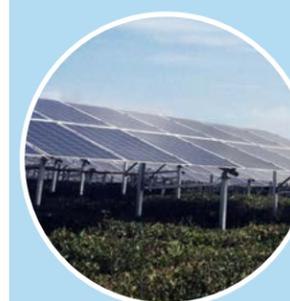
2015 年，天合光能在云南西双版纳的茶园建设了 51MW 农光互补示范项目，在茶树上方架设透明双玻组件，将空间立体高效利用，年预期发电量 8000 万度，可减排二氧化碳 6 万吨。
