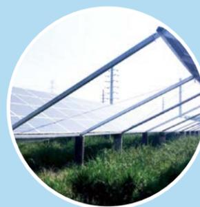
2016 年，天合光能在江苏常州市孟河镇成功建设了 5MW 农光互补示范项目。此项目占地面积约 300 亩，棚内为生态农业，主要有果蔬、中药材种植和渔业养殖。棚顶采用光伏发电，所使用的双玻组件面板有着较强的通透性，可减少组件对阳光的遮挡，保证棚内农作物生长所需光照。
