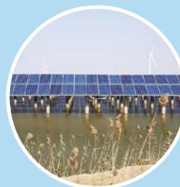
天合光能在江苏省响水市建设了 120MW 渔光互补项目，占地面积约 3853 亩，共安装天合光能组件 480,000 片，是迄今为止华东地区单体容量最大的光伏发电项目。在水产养殖水面上方布置光伏组件，立体布置，做到一地两用，下层为水产养殖，上层用于光伏发电，能极大的提高单位面积土地的经济价值，实现经济效益、生态效益以及社会效益的可持续发展。
