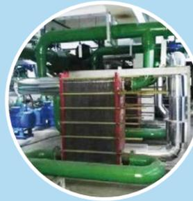
根据工艺要求，多晶铸锭炉需要工艺冷却水（Process Cooling Water, PCW）对设备冷却，以确保设备安全稳定运行。工艺冷却水需要稳定的供水温度，天合光能常州工厂多晶炉工艺冷却水设置的进水温度是 24±1℃。在夏季，需开启冰机以达到进水温度要求，而冰机的开启会消耗大量电能。经设备工程师、工艺工程师与设备厂家共同实验发现多晶炉冷却水进水温度最高可设定在 32±2℃之间，如果把原来的两套冰水板换接入主冷却泵系统，并新增两套冷却水板换，新增换热面积达到 490m<sup>2</sup>，即可利用冷却塔的换热散热来保证炉冷水的进水温度。改造后，每年 5 月~9 月可减少冰水用量，降低冰机能耗，每年节约用电约 122 万度，减少二氧化碳排放 976 吨。
