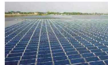
颍上古城 130MW 水面漂浮式光伏电站项目
