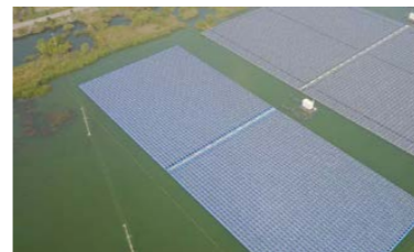
淮北市采煤沉陷区 40MW 水面漂浮式光伏电站项目
