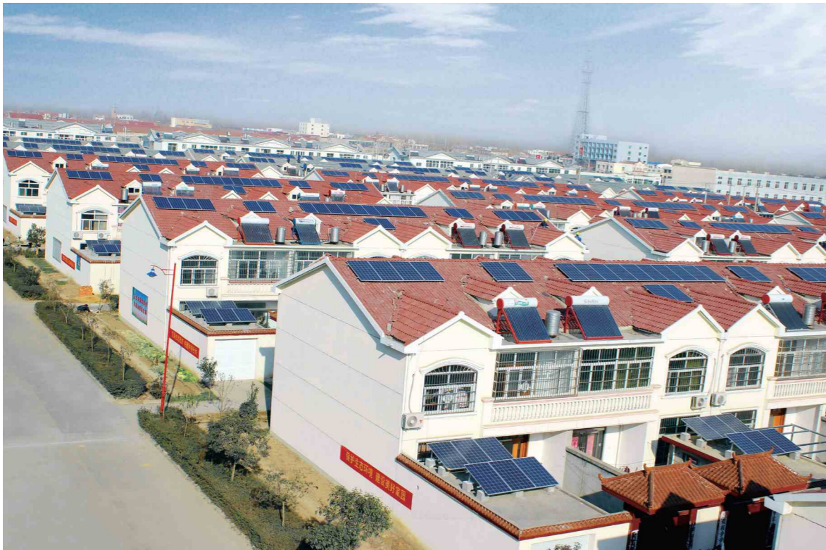
天合光能在连云港市东海县青湖镇青南村建成的全国首个屋顶连片“光伏村”
