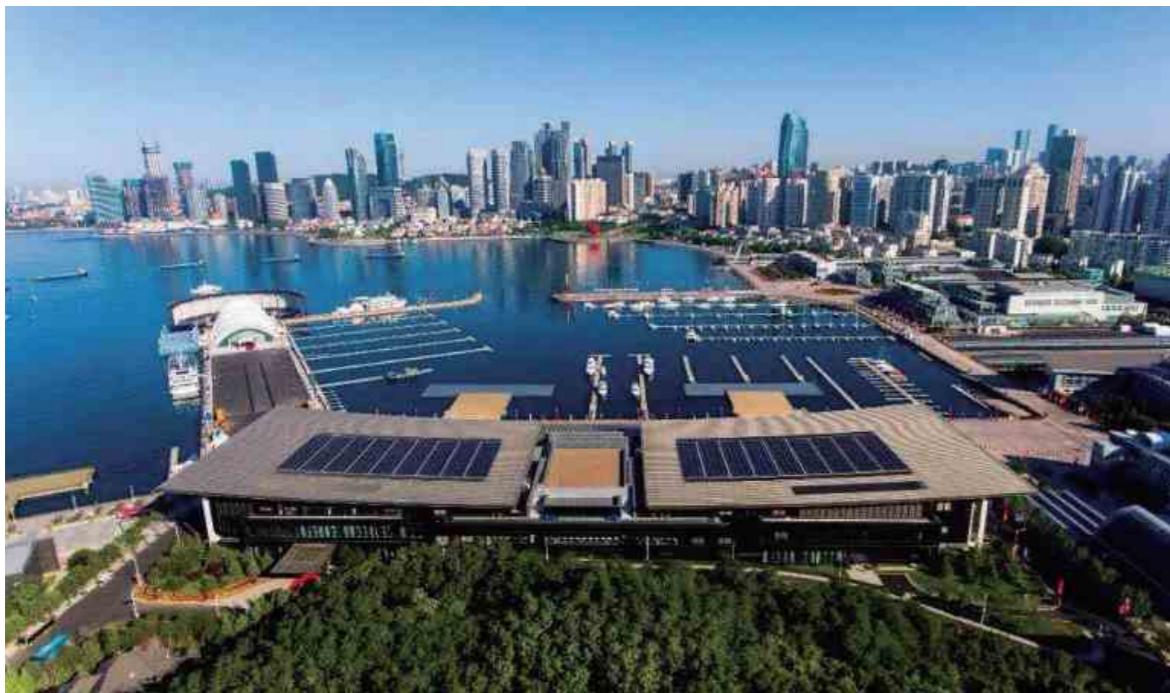
青岛国际会议中心光伏屋顶鸟瞰
