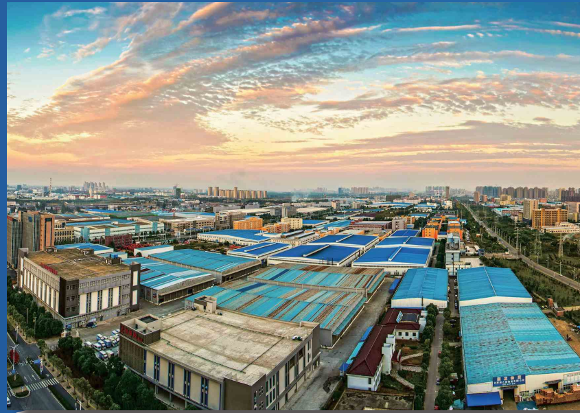
合肥新站互联网+智慧能源国家示范项目
