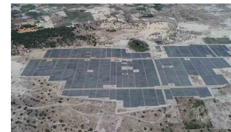
越南 Phong Phu 42 兆瓦光伏项目
