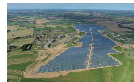
英国诺福克郡 50 兆瓦大型地面电站
