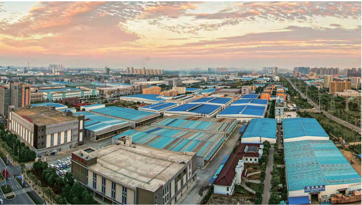
天合光能合肥新站互联网+智慧能源国家示范项目
