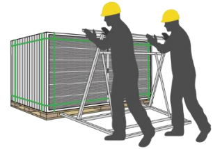
3 放置拆箱靠架，注意靠架应宽于或高于组件防止顶撞玻璃造成组件破损
