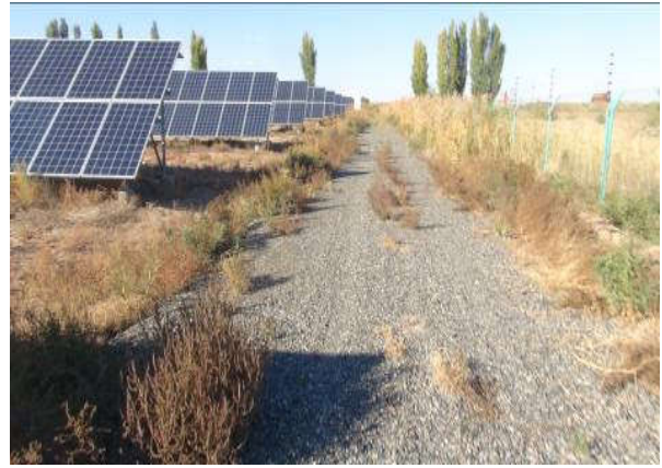
场内道路区周边恢复情况
