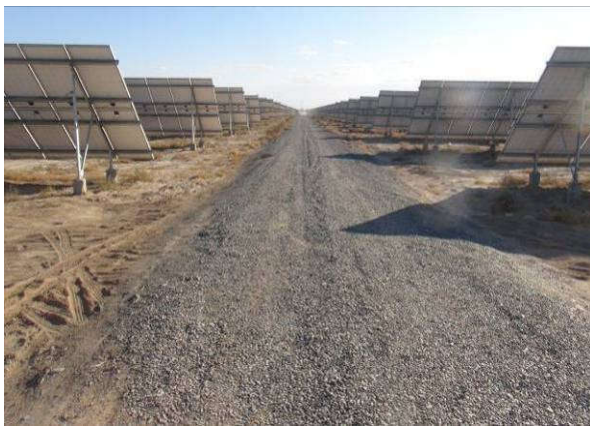
场内道路区砾石压盖措施
