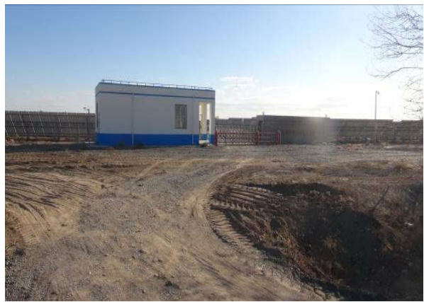
进场道路平整恢复情况
