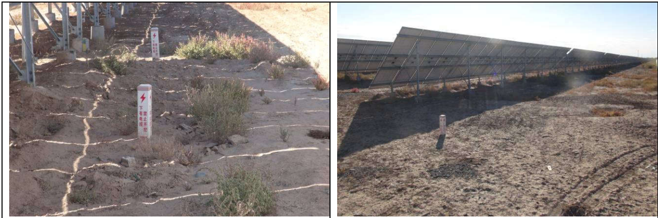
集电线路区现场情况
