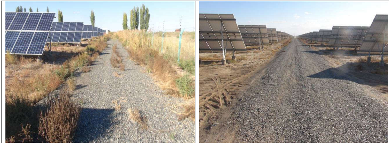
场内道路区现场情况
