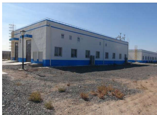
运行管理区平整情况
