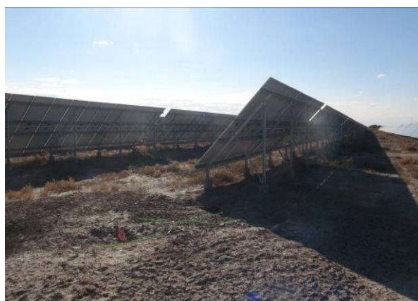
光伏系统区恢复情况
