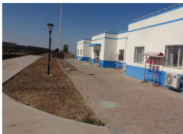
运行管理区平整情况
