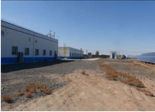
施工生产生活区恢复情况
