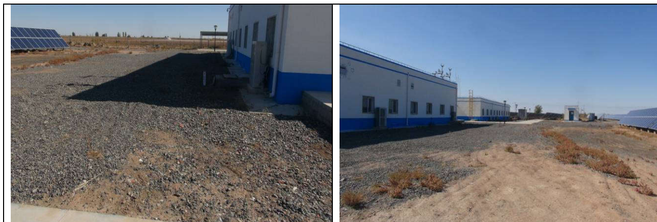
施工生产生活区现场情况
