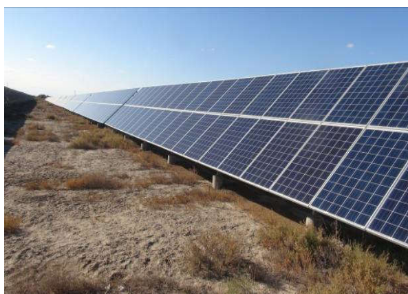
光伏系统区恢复情况
