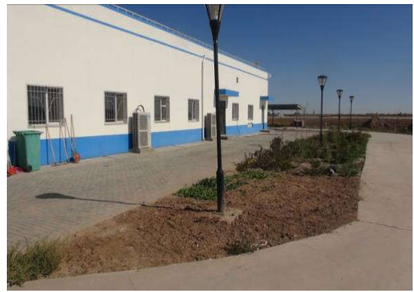
运行管理区植物措施
