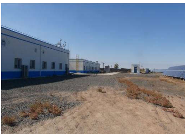
施工生产生活区土地平整
