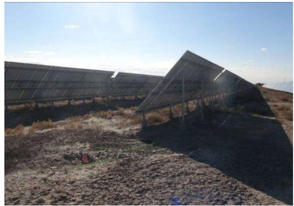
光伏系统区土地平整
