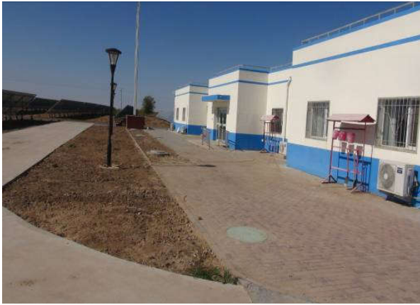
运行管理区植物措施
