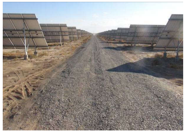
道路区砾石压盖
