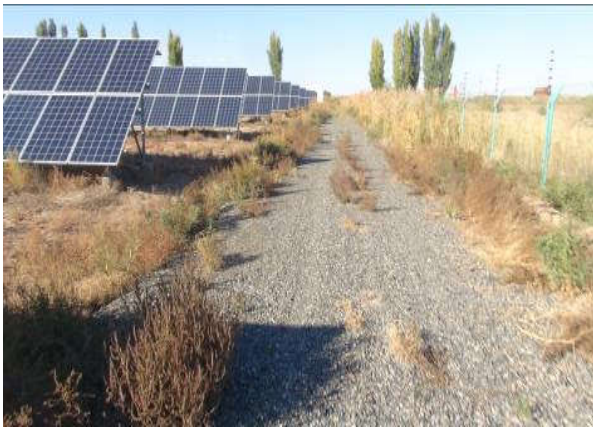
道路区砾石压盖
