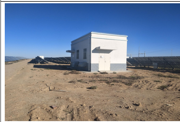
逆变器周边整治情况
