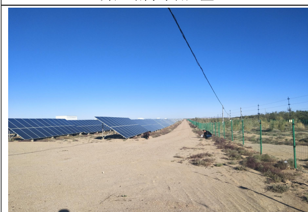
道路砂砾石铺压情况
