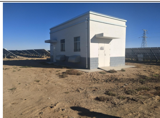
逆变器周边整治情况
