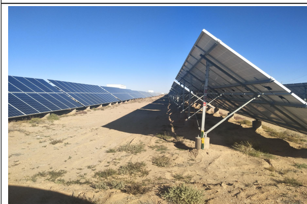
光电池板区整治及恢复情况
