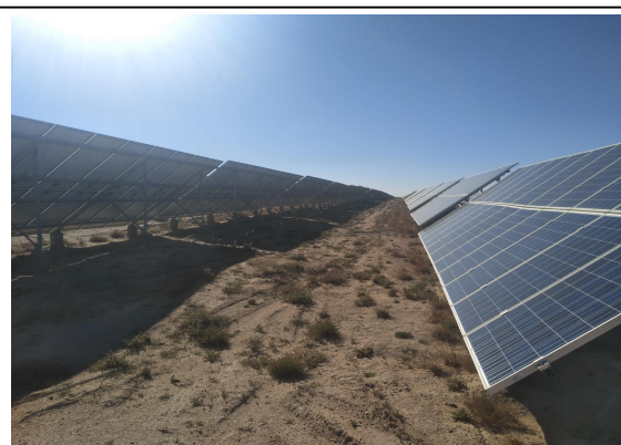
光电池板区整治及恢复情况
