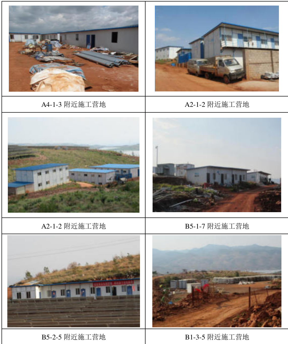
图 4-1 项目临时施工场地
