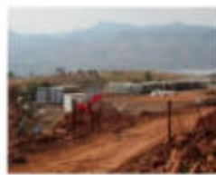
B1-3-5方阵附近施工营地
