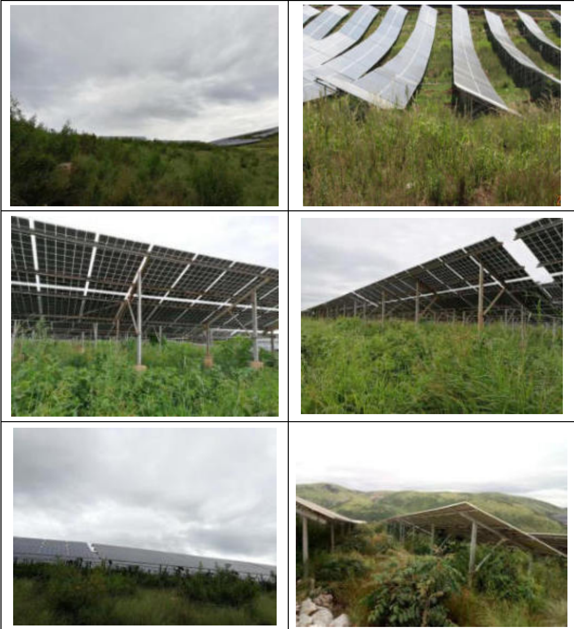
光伏方阵植被恢复
