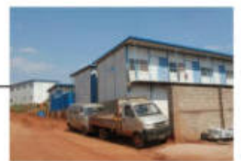
A2-1-2方阵附近施工营地
