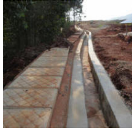
光伏方阵外围截排水沟
