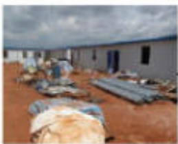
A4-1-3方阵附近施工营地
