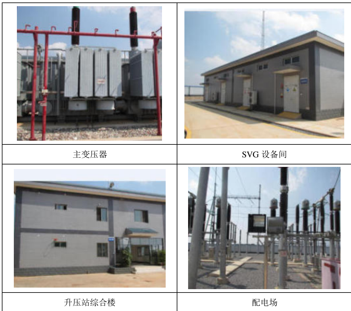
图 7-4-2 升压站电气设备
