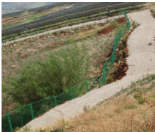
项目外围隔离防护栏及防火通道
