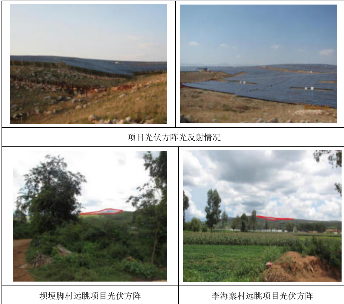
图 7-3 项目光伏方阵图
