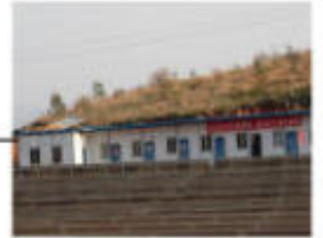
B5-2-5方阵附近施工营地
